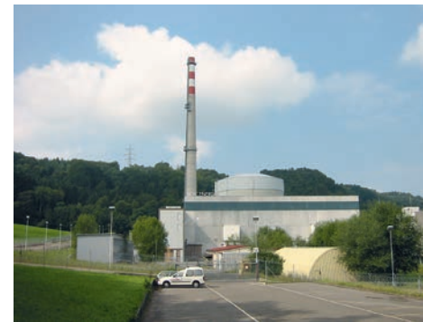
Kernkraftwerk Mühleberg, Quelle: Jürg Joss
