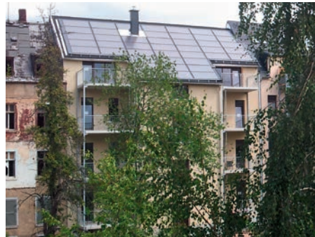
Südseite mit Kollektoren. Links das nächste Gebäude, welches saniert wird.
