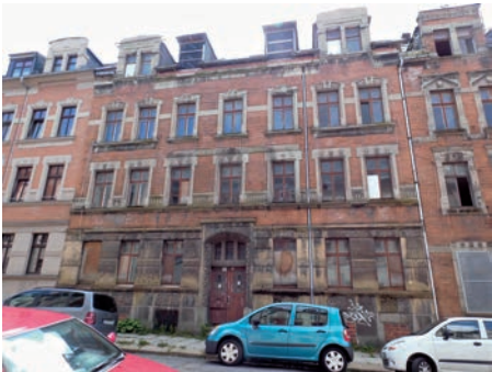
Zustand vor der Sanierung
