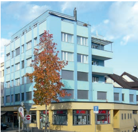
Sanierung Altbau in Romanshorn (vorher/nachher) Quelle: Viridén + Partner AG, Zürich
