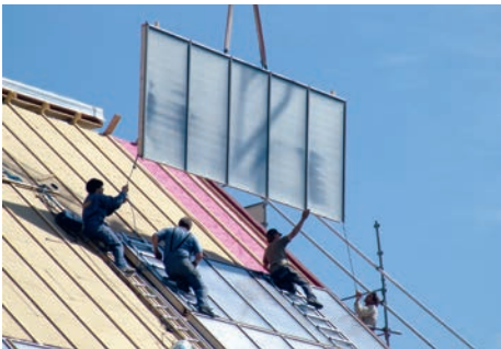
Montage von Sonnenkollektoren
